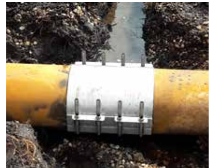
Después de la reparación
