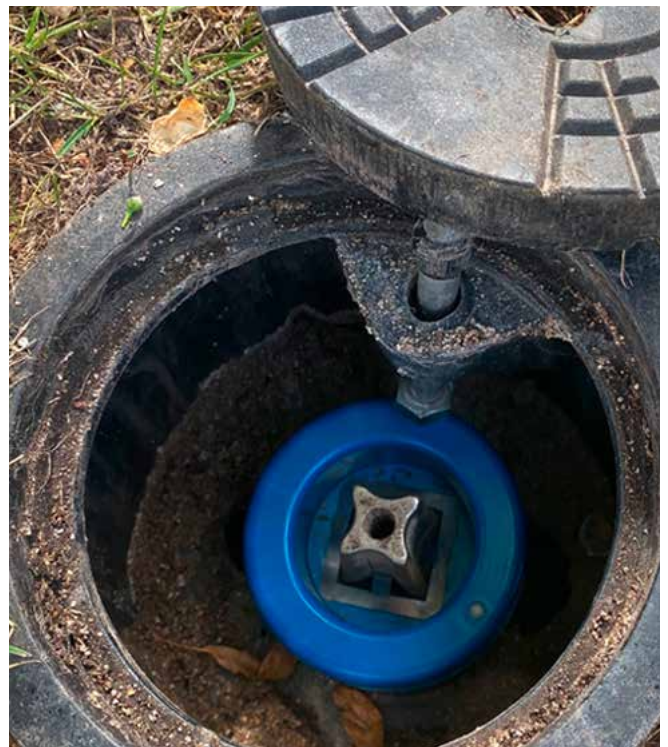
VIDI Positioner instalado en una boca de llave.
