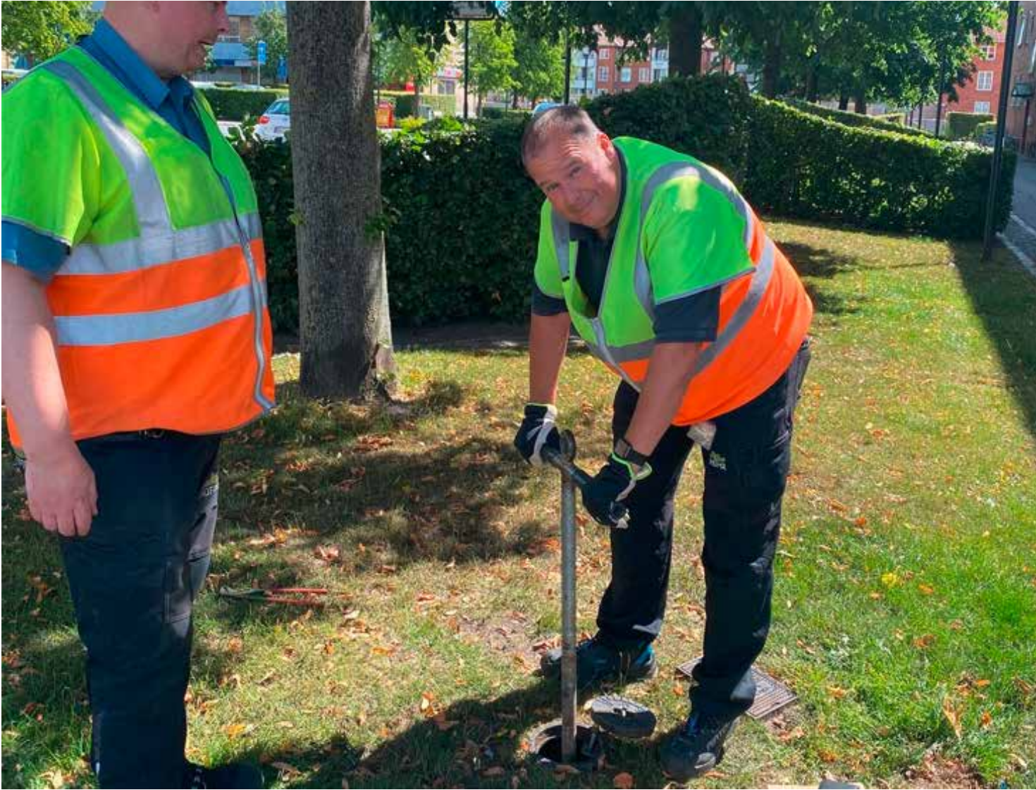
El VIDI Positioner una vez calibrado está preparado para detectar la posición de la válvula de compuerta.
